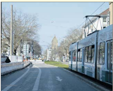
Trotz Baustelle fahren die Straßenbahnen entlang der Habsburgerstraße.
